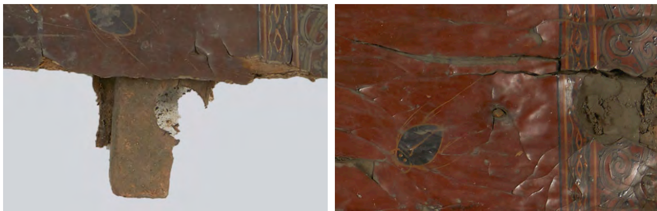
도판 27-1. 두씨작명마각부칠안 ①의 세부 모습(左: 횡목의 마각 장부구멍, 右: 상판과 횡목에 박은 나무못)
