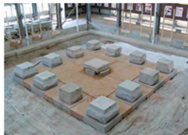
[그림 40] 심초석 및 초석 조립
